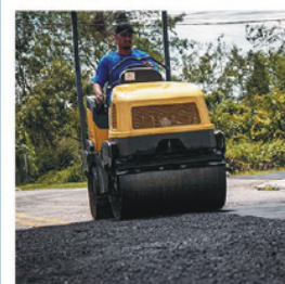
Recapeamento asfáltico em Itacuruçá
